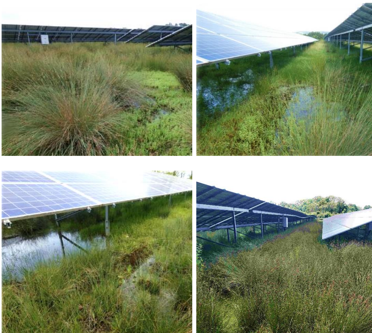
Figure 7 : Pâturages humides à joncs et mares temporaires sur le site de Hauterive (03) en 2021 | Source : Cabinet ECTARE et Luxel
